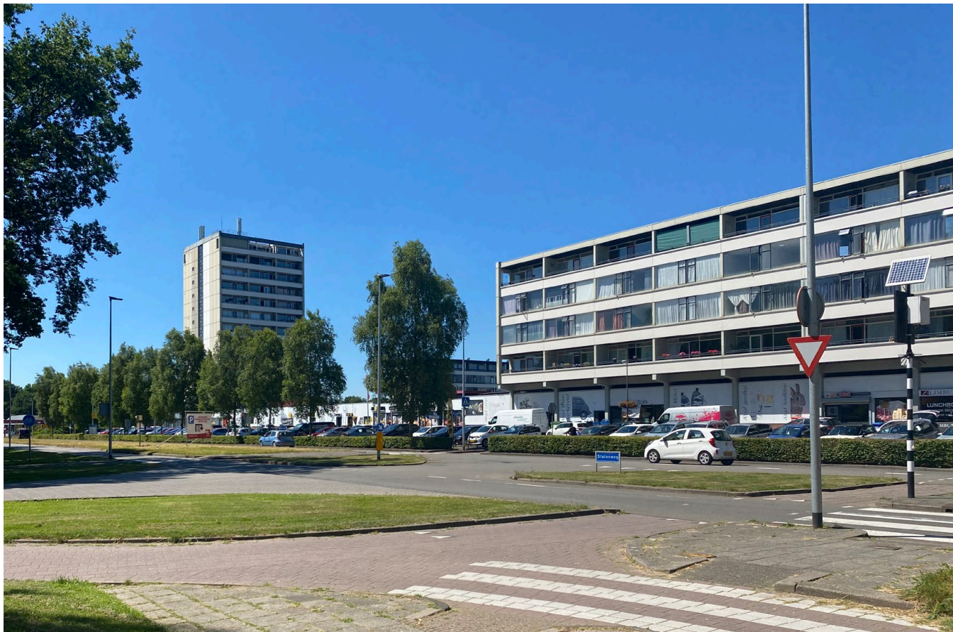
Westkant Het winkelcentrum kan door aanpak van gevel en buitenruimte een betere ‘voorkant’ aan de Statenweg krijgen
